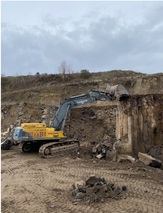
Im Steinbruch Mendig wird seit 1982 Basaltlava im Tagebau gewonnen.
